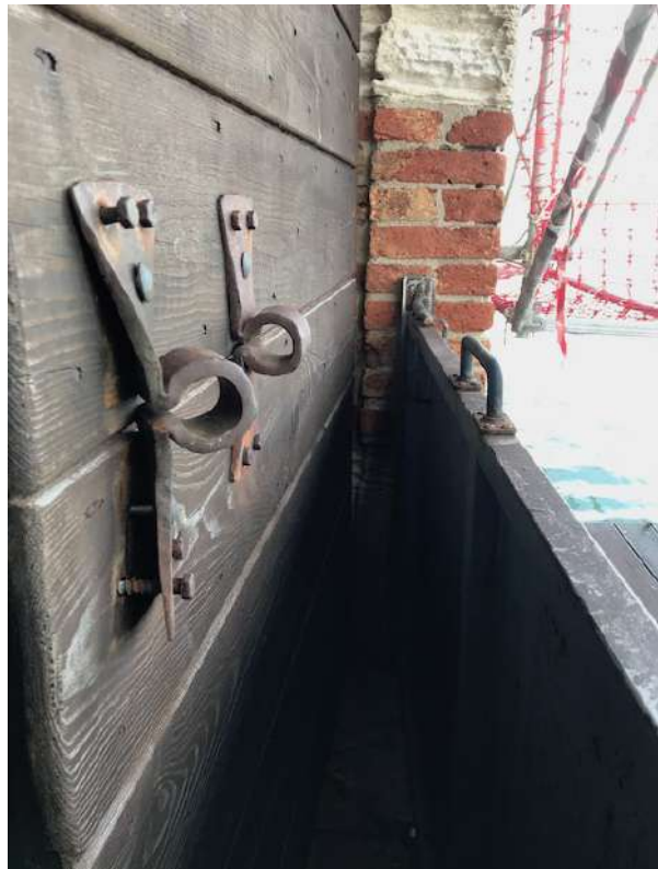
Anordnung der Holztüren der Tesoni, einschließlich traditioneller handgeschmiedeter Beschläge: Scharniere, Scharniere, Riegel, Schlösser, Bleiplomben auf istrischem Stein usw.
