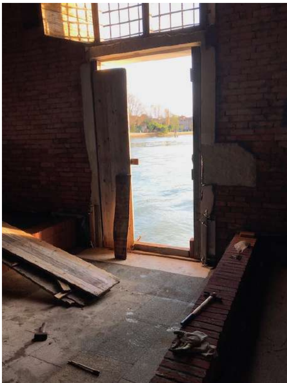
Anordnung der Holztüren der Tesoni, einschließlich traditioneller handgeschmiedeter Beschläge: Scharniere, Scharniere, Riegel, Schlösser, Bleiplomben auf istrischem Stein usw.
